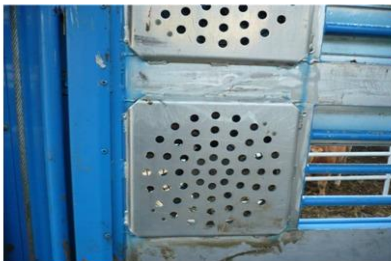
Rys. 9. Przykład niewłaściwej siatki zabezpieczającej wentylator (otwory w siatce są zbyt małe).
